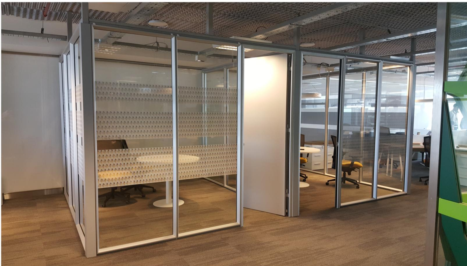
La tabiquería permite dividir, de piso a techo, plantas abiertas, con una gran variedad de tipologías: ciegos (en distintos acabados), vidriados y mixtos, todas combinables en diferentes configuraciones. Su sistema de anclaje permite el monte y desmonte total, incluyendo las fijaciones y sujeciones a los distintos elementos de la mampostería.
